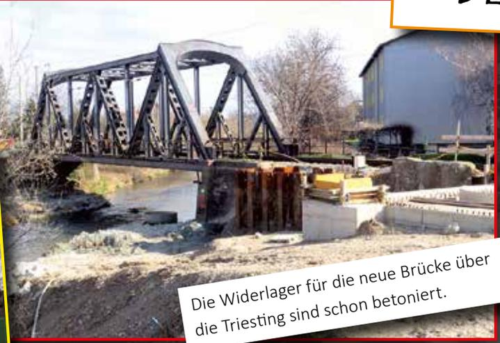
Die Widerlager für die neue Brücke über die Triesting sind schon betonierte.
