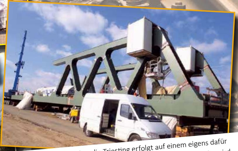
Der Zusammenbau der Brücke über die Triesting erfolgt auf einem eigens dafür asphaltierten Bereich neben der Velmerstraße. Das Einschieben der Brücke wird in der Zeit von 24.7. bis 26.7.2018 stattfinden. Wahrscheinlich wird die Brücke am 24.7.2018 über die L2005 und in den weiteren Tagen bis vor zur Einbaustelle geschoben.
