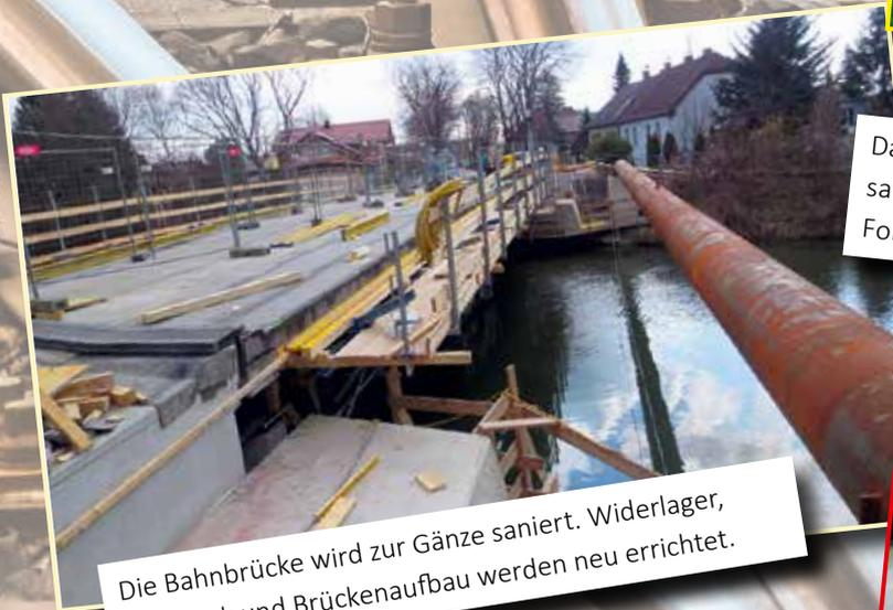
Die Bahnbrücke wird zur Gänze saniert. Widerlager, Tragwerk und Brückenaufbau werden neu errichtet.
