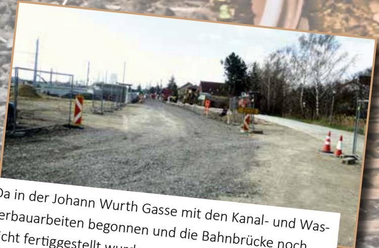
Da in der Johann Wurth Gasse mit den Kanal- und Wasserbauarbeiten begonnen und die Bahnbrücke noch nicht fertiggestellt wurde, musste eine eigene Parallelfahrbahn zur Johann Wurth Gasse errichtet werden.
